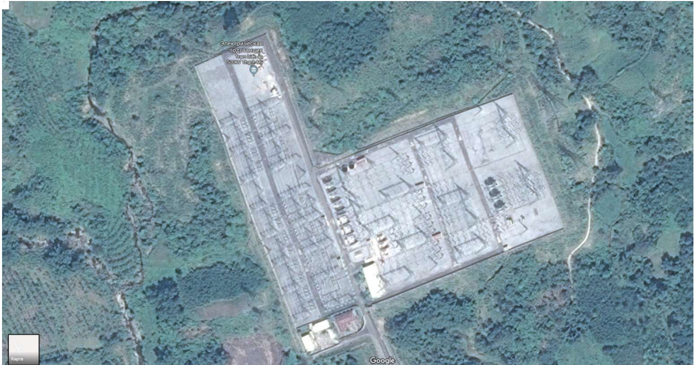
Рисунок 4.10 – Ландшафтный вид трансформаторной подстанции мощностью 500 кВт с масляными трансформаторами Тхань-Ми района Коанг-Нам
