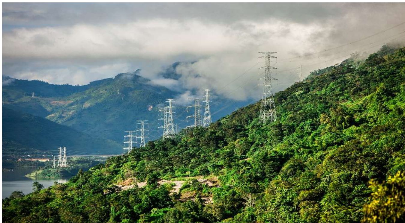
Рисунок 1.18 – Линия электропередачи 500 кВ «Север-Юг» Вьетнама, проходящая через леса провинции Хоа-Бинь (север Вьетнама)
