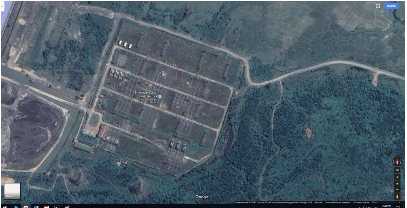
Рисунок 4.7 – Ландшафтный вид трансформаторной подстанции мощностью 500 кВт с масляными трансформаторами Вунг-Анг района Ха-Тинь
